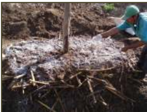
Colocación de Cal
